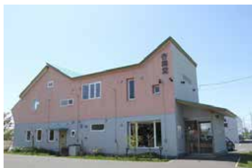
淡いピンク色の外観が印象的な杏園堂鍼灸院。震災後は太陽光発電を導入。屋内はLED電球への切り替えが進む。 杏園堂鍼灸院・アロマセラピースイートバジル 釧路市愛国191-5717 TEL.0154-39-2589 http://anzu946.com/
